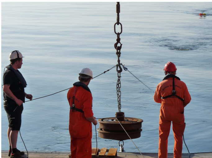
Abb. 2: Ausbringen der Verankerung auf 39°10' N und 18°0' O bei spiegelglatter See
